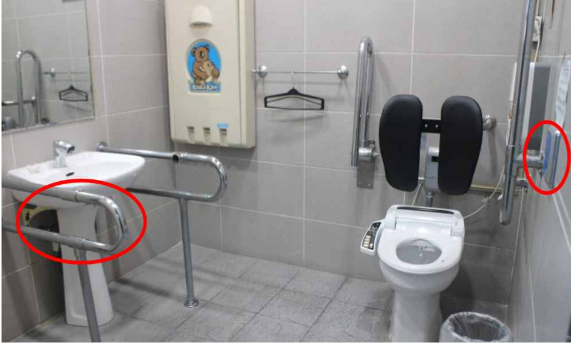
[ 그림 5-4 ] 창원종합버스터미널 화장실 내부
