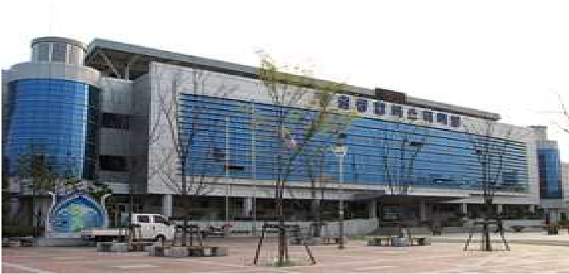
[ 그림 3-1 ] 창원종합버스터미널 외부전경
